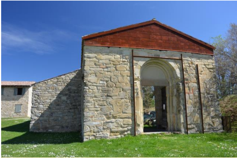
La facciata della Pieve
